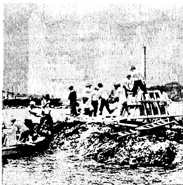
写真4. 標識柱設置風景.
