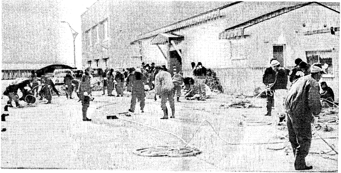
写真-4 H10年海中林設置作業
