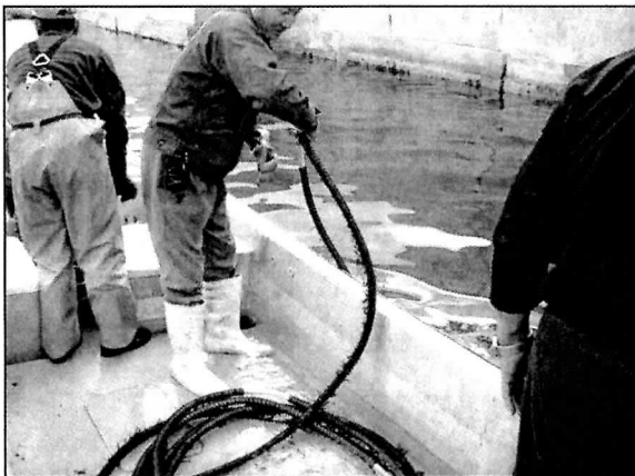
図6 沖出し作業①
