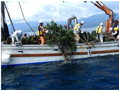
写真1 原木魚礁設置作業
