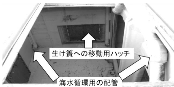
図4 運搬船の魚槽内のハッチや配管
