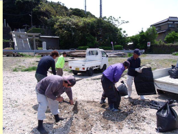
②土の上に土砂を詰込み
