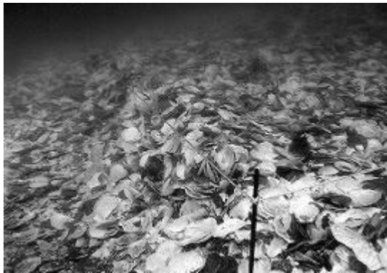
図-6 貝殻敷設状況
