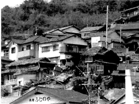
震災被害の状況
