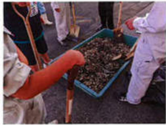
図5 底質改善剤散布状況
