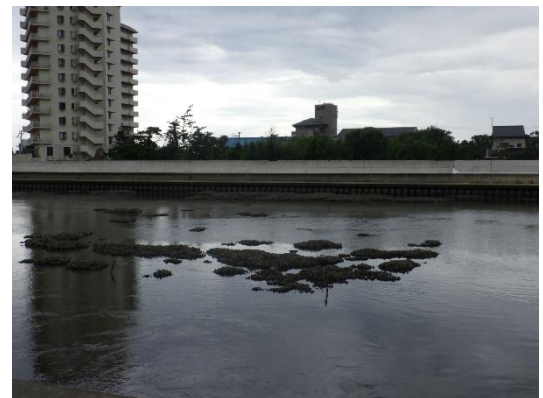
図 11 工事後のカキ礁の状況
